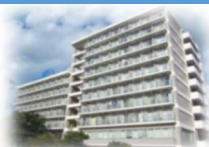
下愛子県職員寮 (仙台市青葉区)
