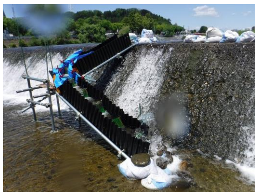
図1 角型ハーフパイプ式簡易魚道
