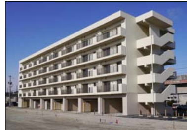
災害公営住宅整備状況 (塩竈市北浜地区)
