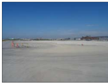
焼却炉解体後の状況 (石巻ブロック)
