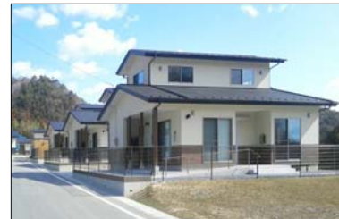
災害公営住宅整備状況 (女川町竹浦地区)
