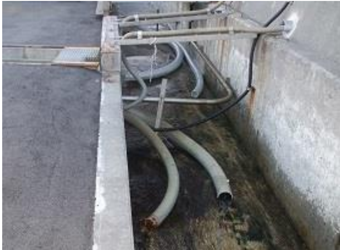
現在の排水路の状況
