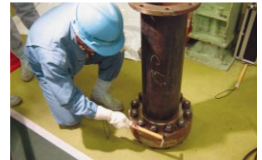
基礎ボルトの打点点検
