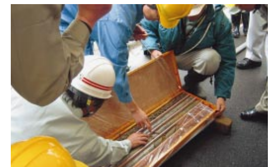
1号機の原子炉建屋基礎地盤点検状況
