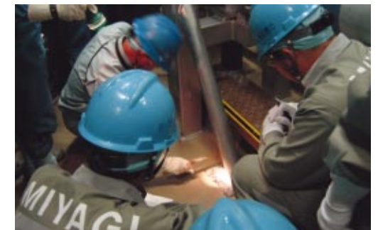
支持構造物の打点点検
