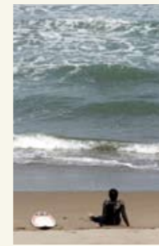
【長面海水浴場】海岸の砂浜浸食が進み、海水浴場が閉鎖される事態にもなった。現在、砂浜浸食を防止するための工事が行われている。
