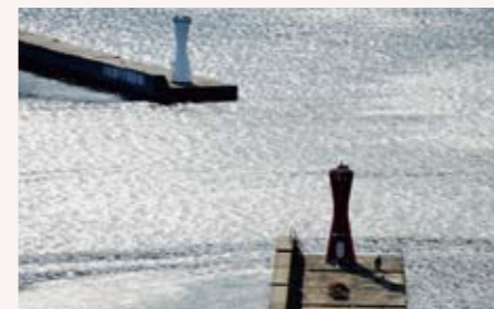
【湾口防波堤】崎山展望公園から女川湾に目をやると、湾をふさぐように南北から防波堤が伸びている。津波の被害から女川港を守るための防波堤である。
