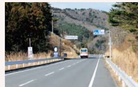
【町境】指ヶ浜を過ぎると、石巻市雄勝との町境となる。ここからは雄勝半島白銀崎を見渡すことができる。
