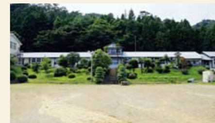
【石巻市立大須中学校】大須中学校の校舎は、昭和26年雄勝町立船越中学校大須分校として開設した際、地域住民の手によって建てられた木造校舎で、手直ししながら大切に使用されている。小高い丘にある校庭からは太平洋を遠く望むことができる絶好のロケーションとなっている。
