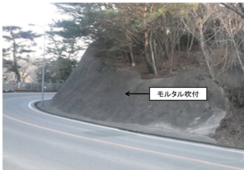
図 モルタル吹付工の施工例(構内道路)
