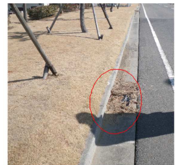
写真A 構内道路に残留した塵芥
