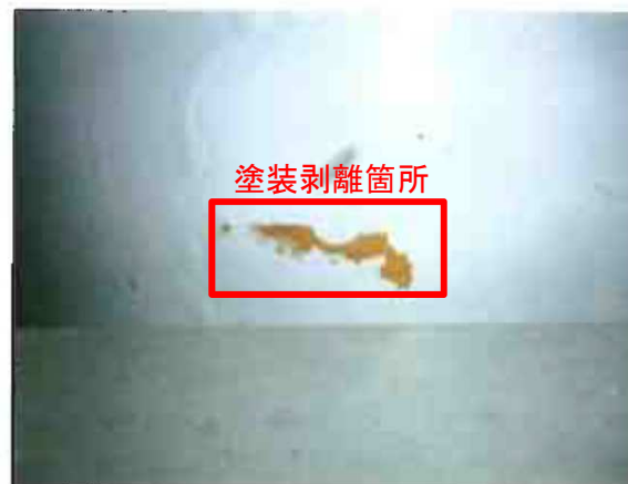
①の矢視 (サポート斜め上から)
