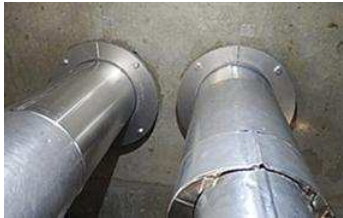
配管貫通部 止水処置(再施工)
