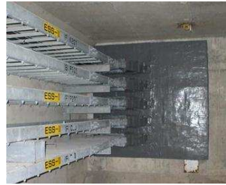
電路貫通部止水処置 (再施工)
