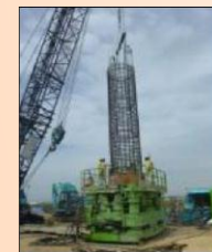
常磐線の本体工事に着手
