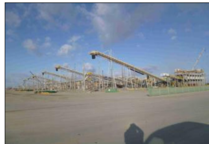
粉碎選別施設の解体の状況 (石巻ブロック) (石巻市)
