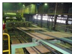
復旧した合板工場
