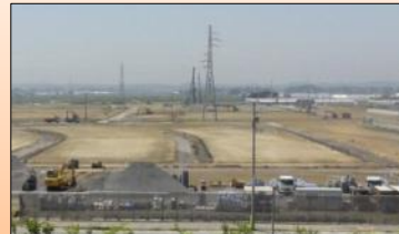
新蛇田地区工事状況(石巻市)
