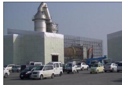
焼却炉解体のための覆い作業の状況 (亶理名取ブロック (山元処理区)) (山元町)
