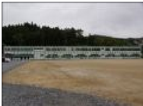
仮設校舎 (宮城県気仙沼向洋高等学校)
