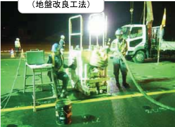
耐震整備工法 (地盤改良工法)
