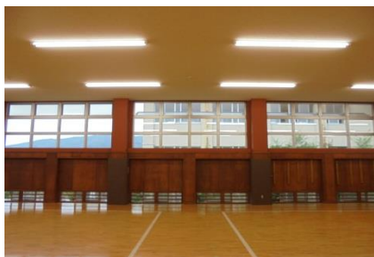
柔剣道場天井改修（着手前）
