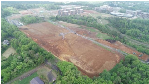
敷地造成工事施工状況
