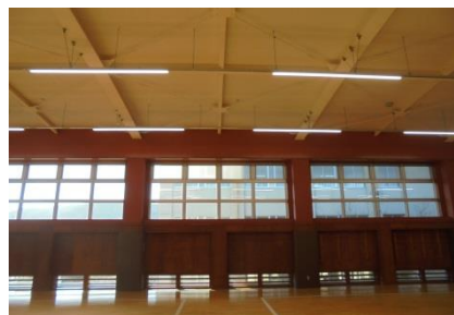
柔剣道場天井改修（完成）
