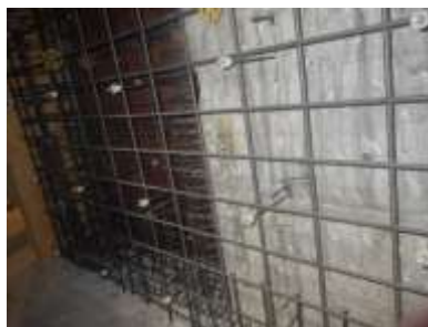
改修工事の状況
