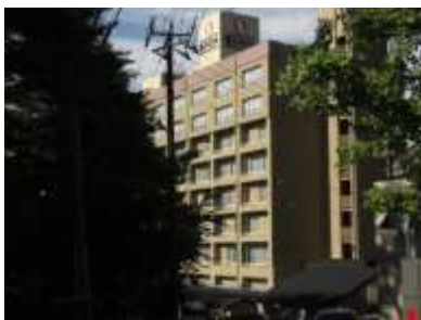
耐震改修完了(鳴子ホテル)
