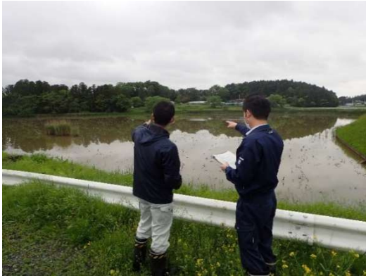
▲ため池点検の様子
