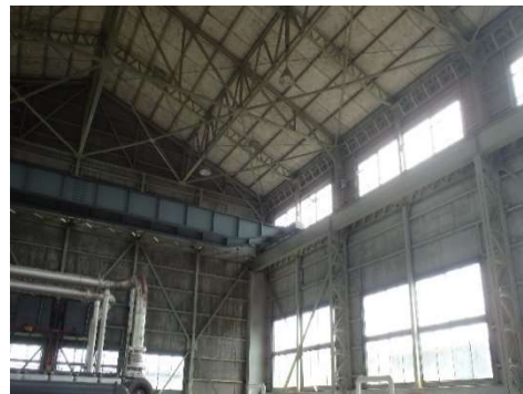
▲低濃度 PCB 廃棄物：建屋鉄骨・クレーン等塗膜
