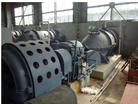
▲低濃度 PCB 廃棄物：ポンプ等機器類塗膜
