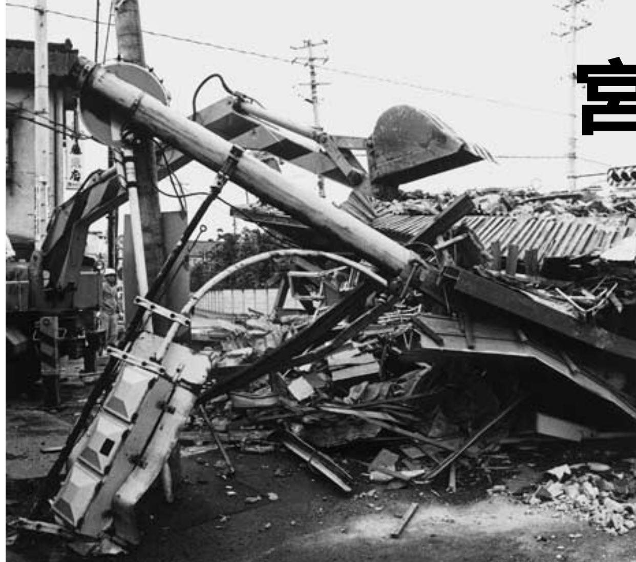
倒壊した長町地区の住宅(仙台市)
