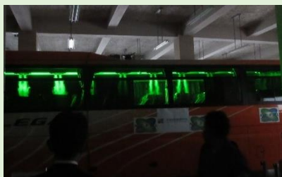
屋根上のエアコンユニットから、車外のフレッシュな空気が大量に流入
