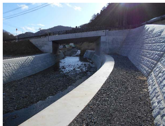
(主) 女川牡鹿線 八幡橋（石巻市）
