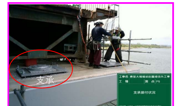
(支承の設置作業)
