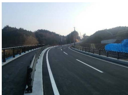
一般県道泊崎半島線外1路線 (南三陸町)
