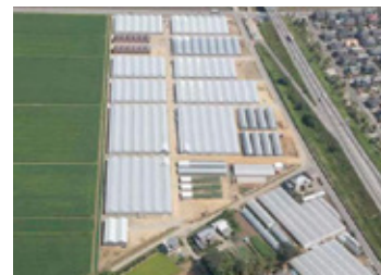
写真：石巻市蛇田地区の大型野菜生産施設
