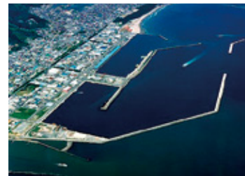
写真：石巻漁港の復旧状況
