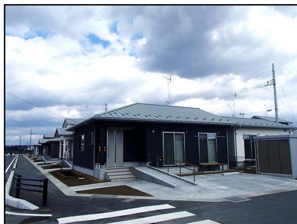
柳の目西地区 (東松島市)
