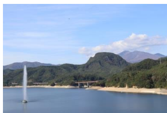
七ヶ宿ダム（右岸道路）
