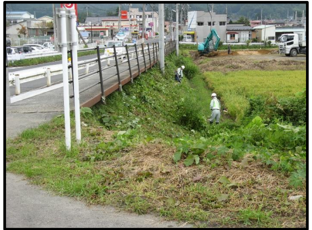
団体名：岩倉測量設計(株)【ロード】 実施日：H30.9.15 箇所名：(国)457号 活動内容：ゴミ拾い・歩道，路肩，法 面の除草作業
