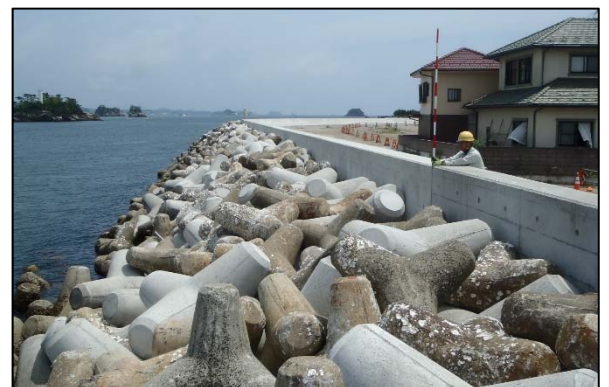
代ヶ崎清水護岸 (七ヶ浜町)
