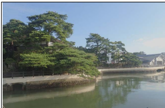
海岸通り護岸 (松島町)
