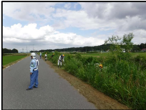
団体名：(株)伊藤土建【リバー】 実施日：H30.6.19～20 箇所名：芋塚川 活動内容：小堰橋から芋塚橋までの左 岸500mの除草作業
