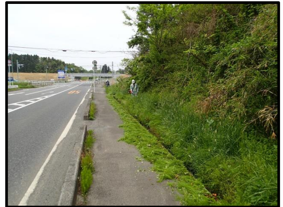
団体名：(株)野口重機【ロード】 実施日：H30.5.12 箇所名：(主)築館登米線 作業内容：除草作業
