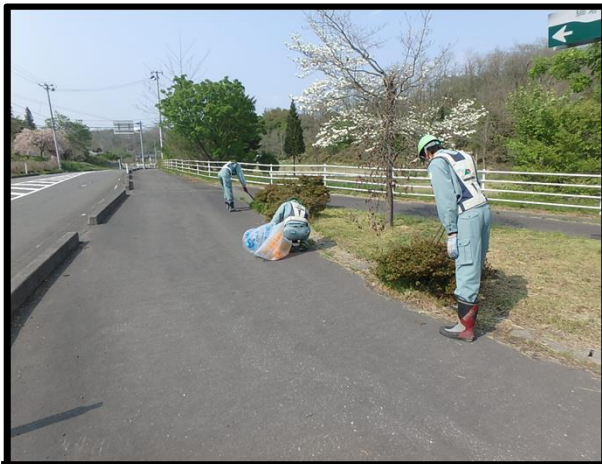
団体名：日本植生(株)仙台営業所 【ロード】 実施日：H30.5.1 箇所名：(一)文字下細倉線 活動内容：道路の清掃作業
