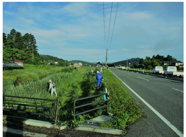
団体名：長崎川を愛する会【リバー】 実施日：H30.7.1 箇所名：長崎川 活動内容：地区の皆さんと(国)398号線沿いの除草作業
