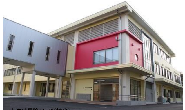
↑生徒昇降口(新校舎)
