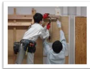
電気科 （登米電気工事事業協同組合青年部交流事業）
