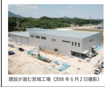
建設が進む宮城工場 (2018年6月2日撮影)
