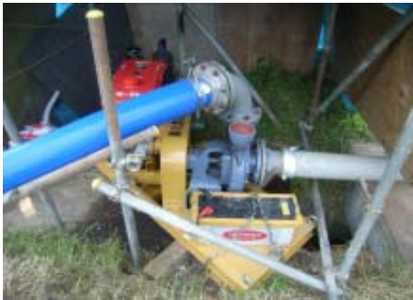
最下流部(取水)ポンプ( 150、揚程20m、2m 3 /min)
