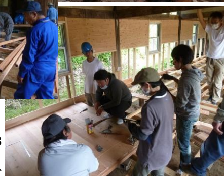
2017. 10. 8 「リノベーション交流イベント」 床張り作業指導の様子
