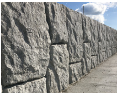
浜田漁港、海側の防潮堤。
