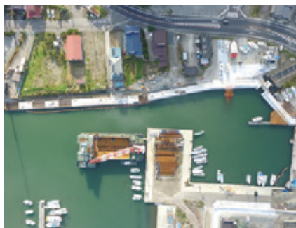
防潮堤整備が進む浜田漁港
