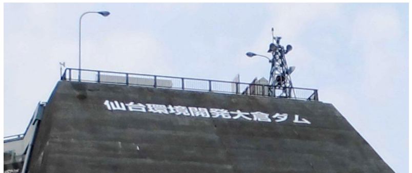
別添図3 ダム堤体への愛称表示
