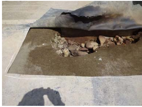
●2 ゴムシート裂け目【洪水吐付近】※切り開き寸法 2.0m×0.5m
