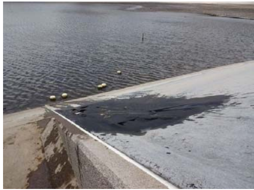
●2 ゴムシート裂け目【洪水吐付近】※切り開き寸法 2.0m×0.5m
