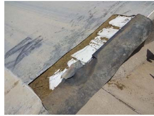
●2 ゴムシート裂け目【洪水吐付近】※切り開き寸法 2.0m×0.5m
