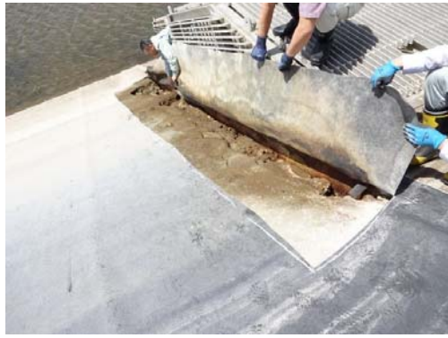
●2 ゴムシート裂け目【洪水吐付近】※切り開き寸法 2.0m×0.5m
