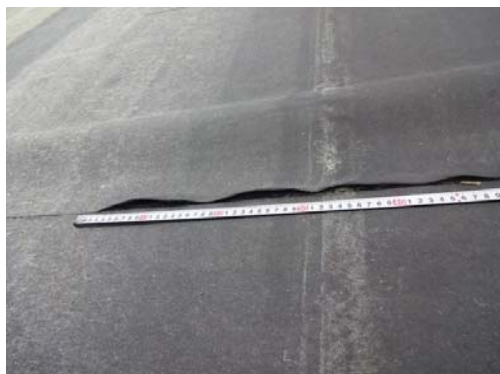
④その他（重ね合わせ部分の剥がれが貫通）
