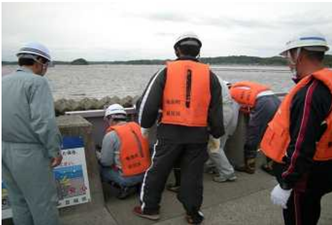
点検作業状況
