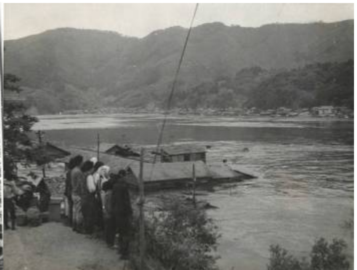
【チリ地震津波：雄勝町の被災状況】
