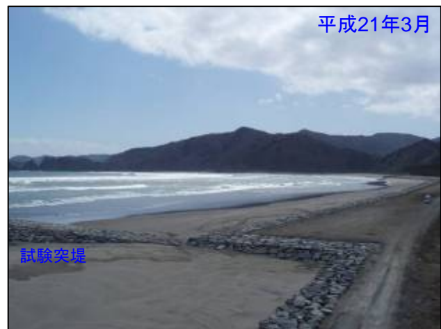
【石張護岸工及び試験突堤が完成】
