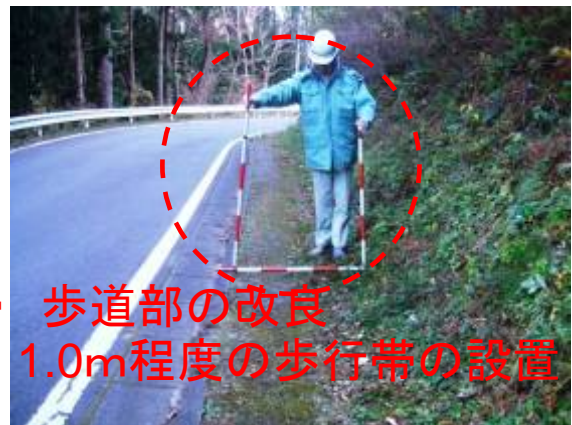
車道部の改良 現道幅員4.0m→改良5.0m
