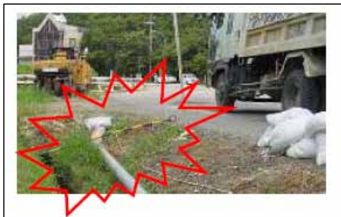
標識等の損傷
