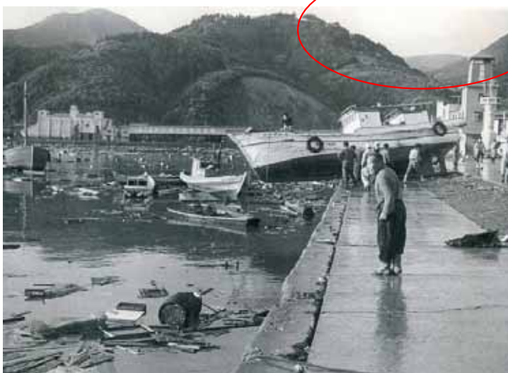
チリ地震津波による被害写真
