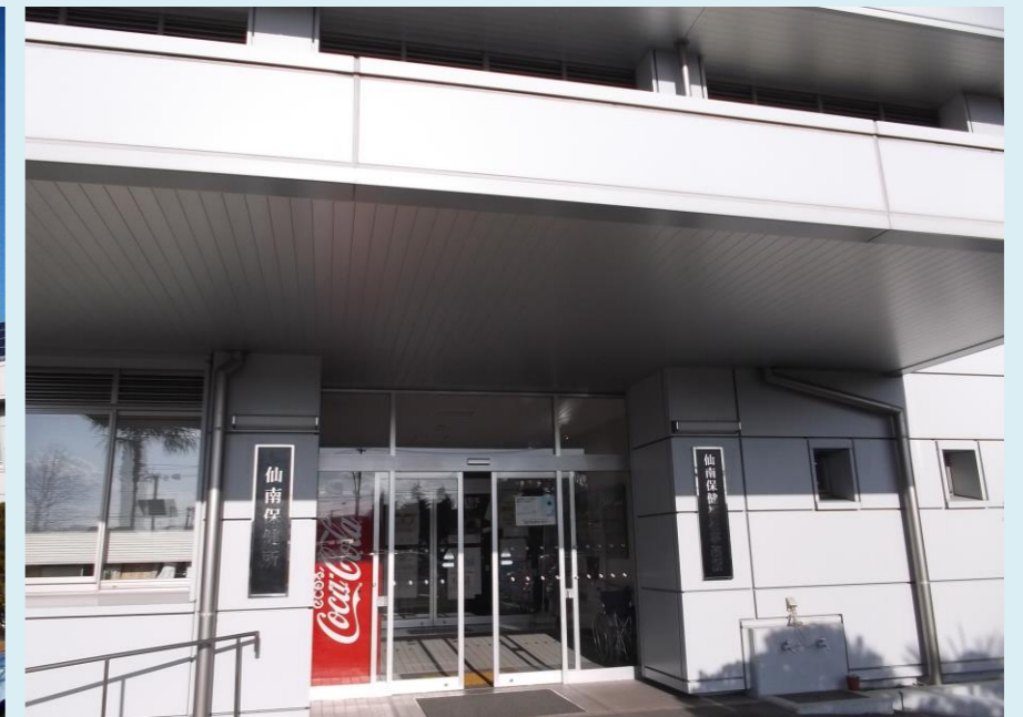
<保健所棟入口>
