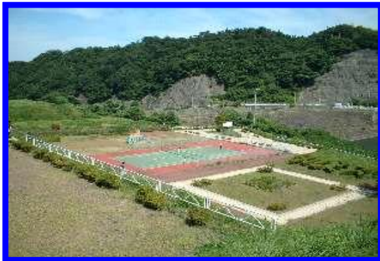
湖畔公園(左岸下流側)
