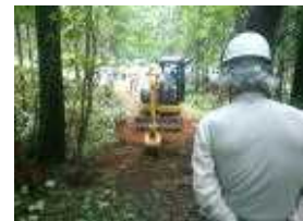
【作業道の開設】
