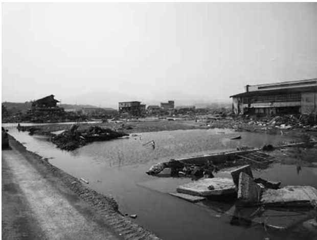
気仙沼市内の被害状況（平成23年4月）
