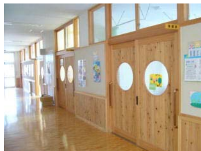
◇内装木質化の状況
