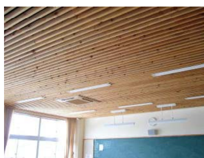
天井のスギ材使用状況
