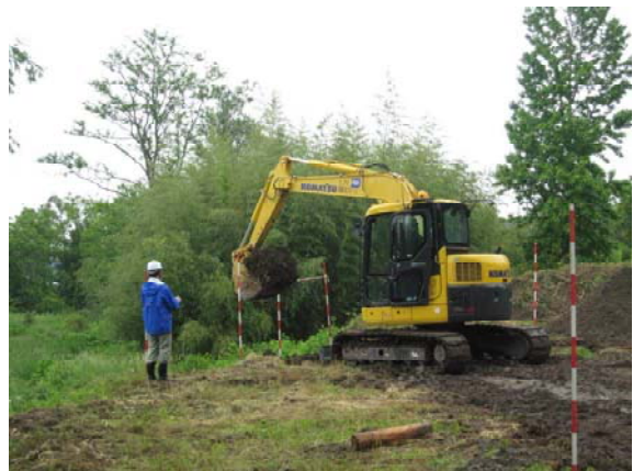
車両系建設機械運転技能講習の実施状況
