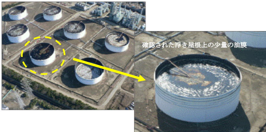
図 4.1.4 浮き屋根上の少量の油膜
