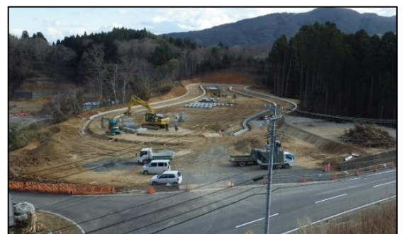
鮫浦地区 造成工事状況(石巻市)
