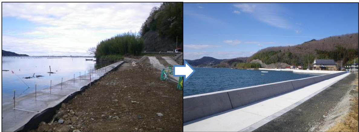
安住海岸の護岸工 完成状況（石巻市）
