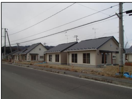
新山下駅周辺地区第2期 完成状況（山元町）
