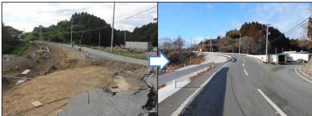
県道清水浜志津川港線 志津川字深田地内 完成状況（南三陸町）
